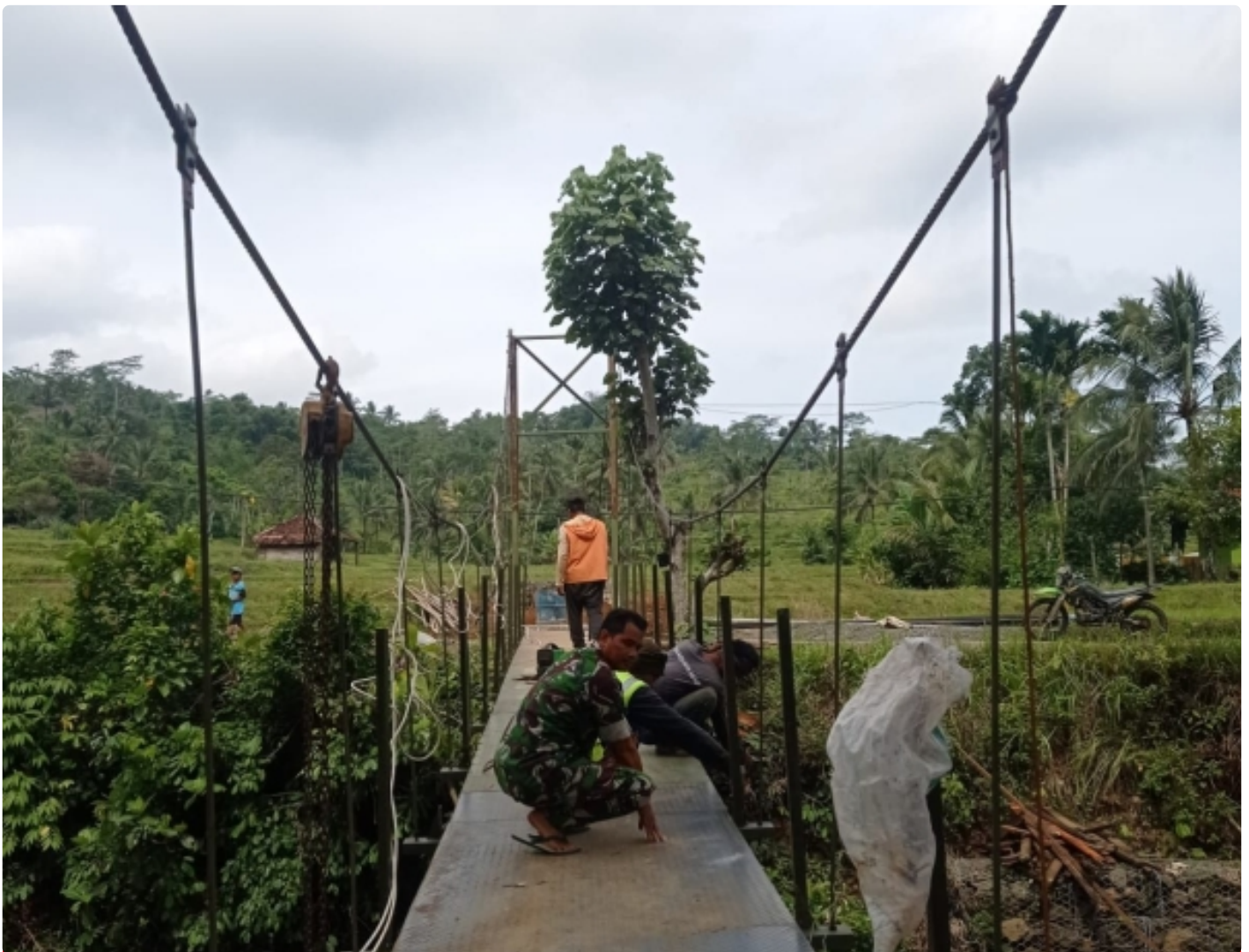
Kpt Arm Witono: Pengerjaan Jembatan Gantung Sudah 80%
